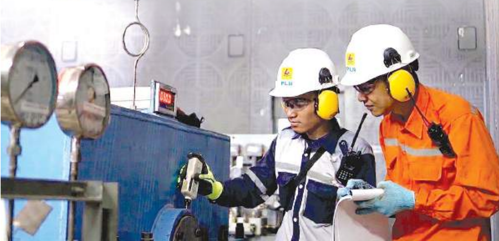
PETUGAS PLN melakukan pekerjaan pemeliharaan infrastruktur ketenagalistrikan sebagai bagian dari upaya mempercepat pemulihan dan menjaga keandalan sistem kelistrikan di Sulbagsel. FOTO: IST
