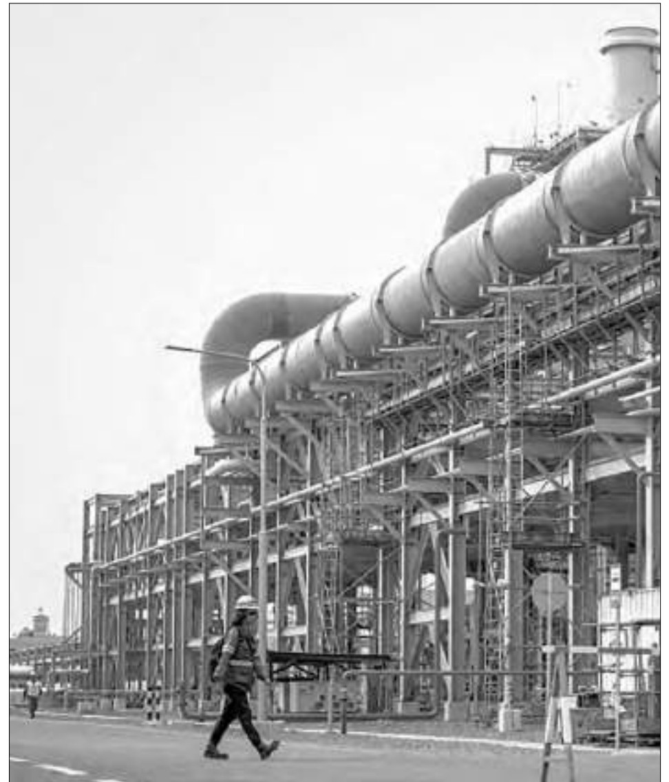
PEKERJA berjalan di lokasi Smelter PT Freeport Indonesia (PTFI), Kawasan Ekonomi Khusus (KEK) Gresik, Jawa Timur, Kamis (6/2/2025). Fasilitas Smelter PTFI yang mengalami kebakaran pada Senin 14 Oktober 2024 tersebut direncanakan mulai beroperasi kembali pada akhir Juni 2025 dan secara bertahap akan mencapai tingkat produksi 100 persen pada akhir tahun 2025. FOTO: ANT
