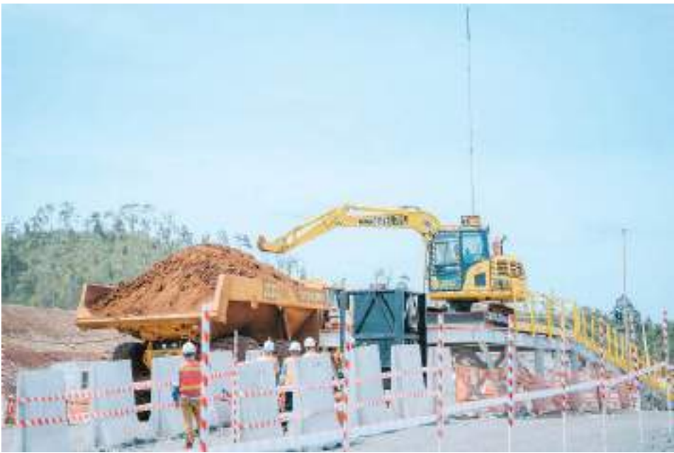
PENGANGKUTAN ore perdana di PT Vale IGP Pomalaa. FOTO: DOK. PT VALE
