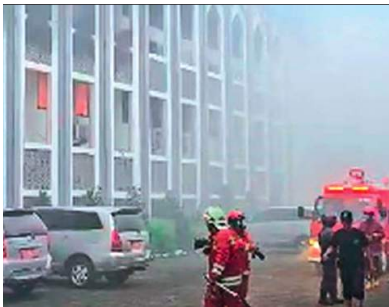
GEDUNG Rektorat UIN Jakarta yang terbakar, tampak sejumlah Mobil Damkar yang terus bersiaga melakukan pemadaman. FOTO: IST
